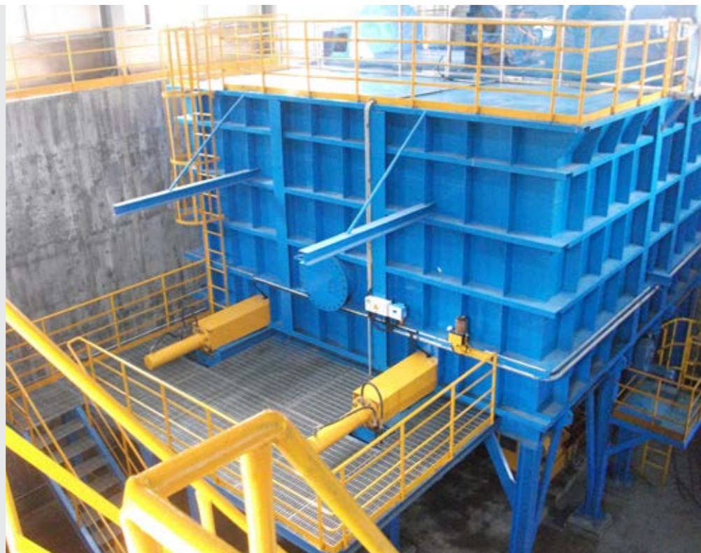
Oben: Platzsparender und bewährter Einbau der Antriebszylinder in den Siloboden
