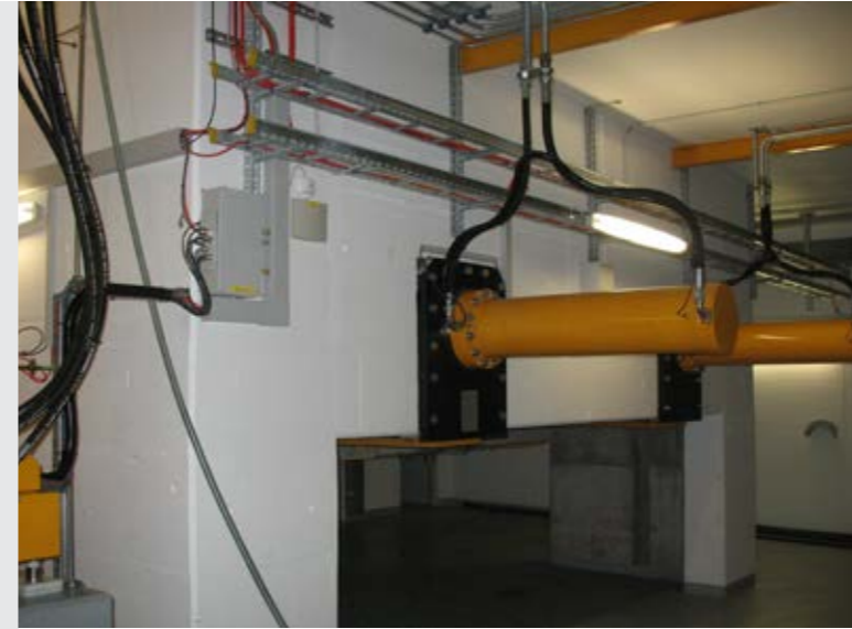
Gleitrahmenzylinder in einem Betonsilo, Klärwerk Oftringen, Schweiz
