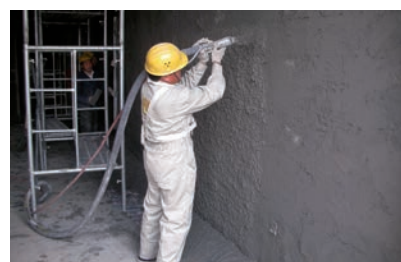
Spritzen von Innenputz
