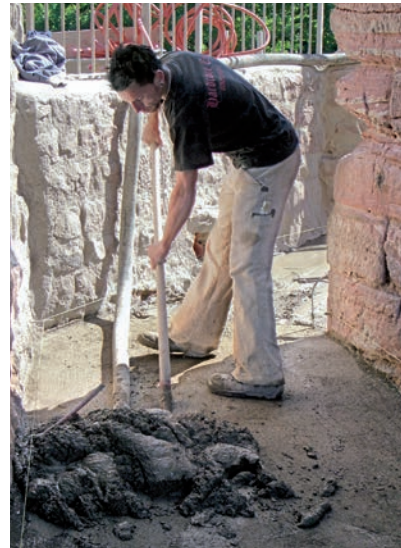
Förderung von Feinbeton bis 8 mm
