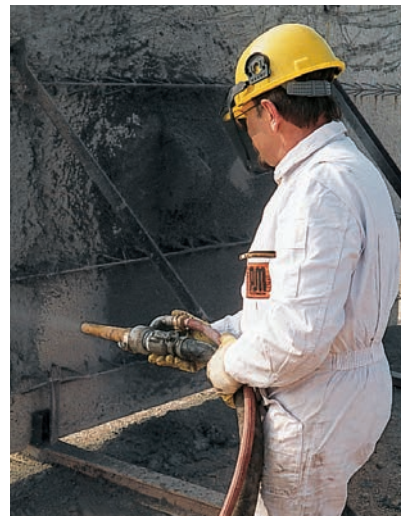
Spritzbeton bis 8 mm
