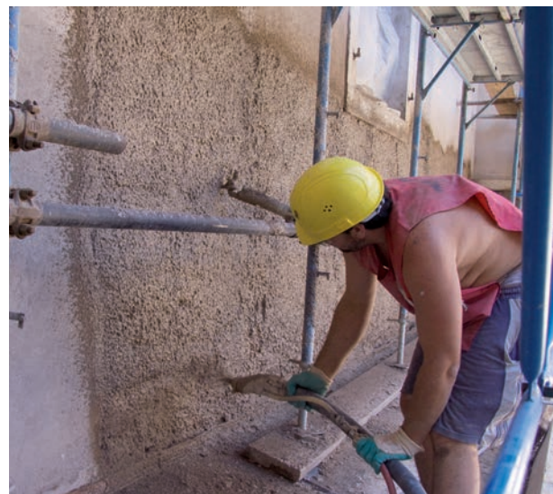
Spritzen von Außenputz
