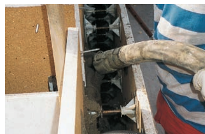
Verfüllen von Schalungssteinen
