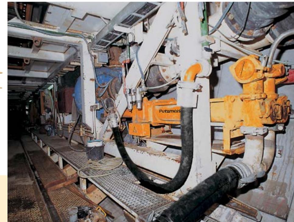
Eine KOV 1050 pumpt Injektionsmörtel hinter die Tübbinge
