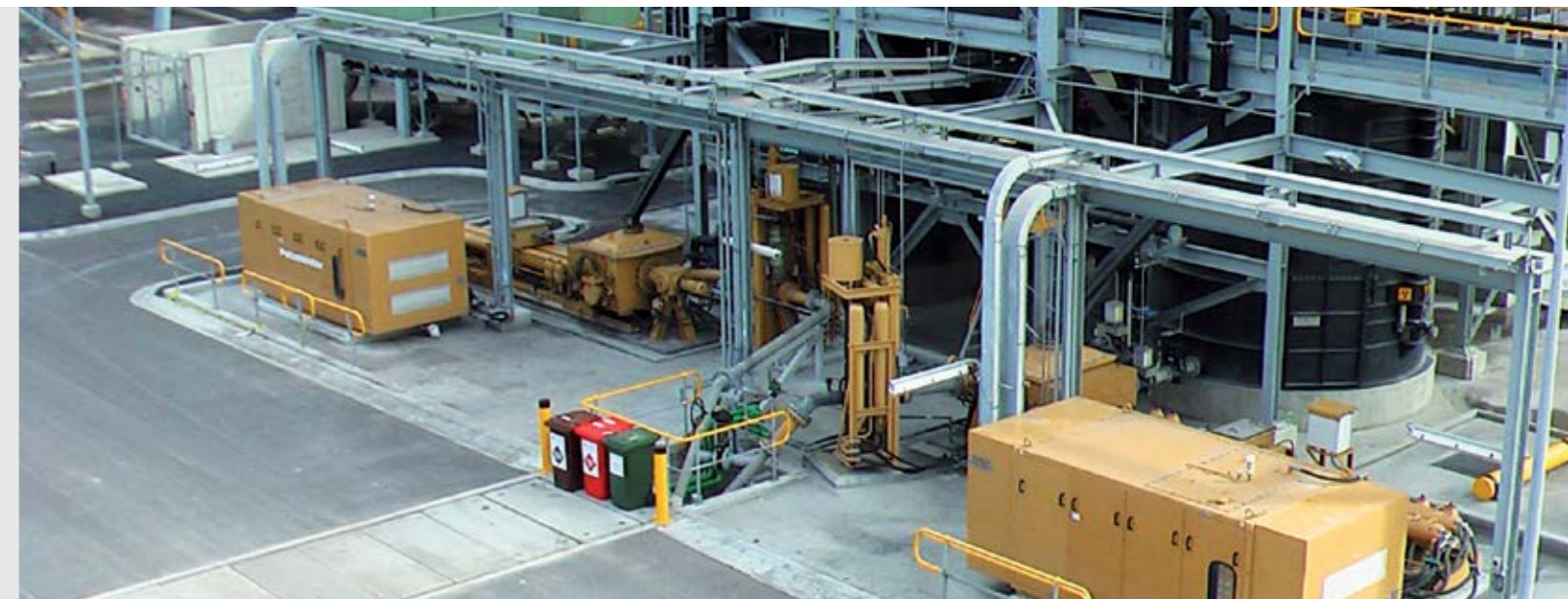
Redundanter Flug- und Bodenäschetransport aus einem Kraftwerk
